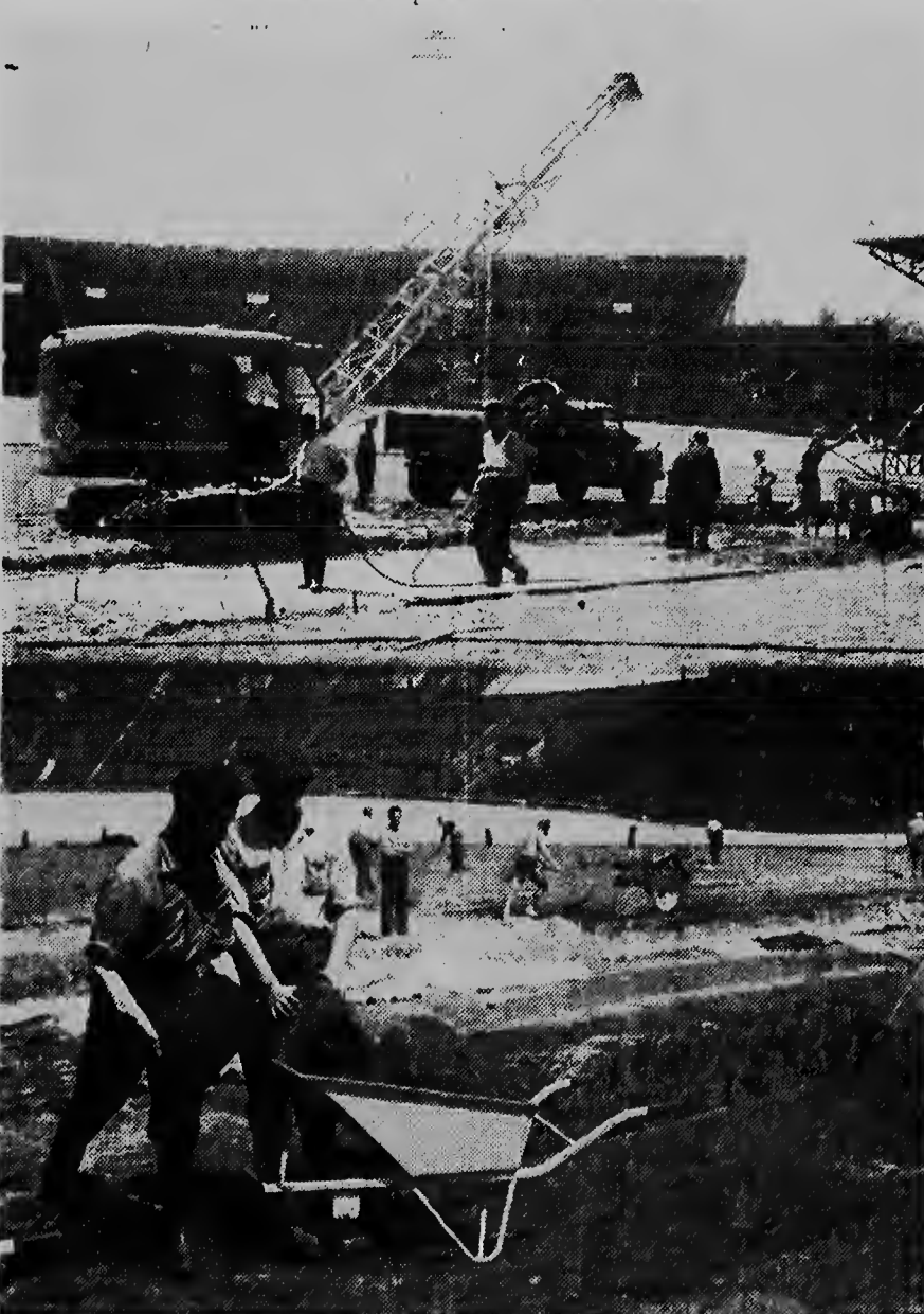
De grasmat van het Olympisch stadion te Amsterdam wordt douchig onder handen genomen: het gras wordt in lange banen gesneden, die zorgvuldig worden opgerold; nadat het onderliggende zand ververst is opgehoogd is, worden de banen n.l. weer netjes uitgelegd. Deze twee foto's geven een beeld van de bedrijvigheid in het stadion; op een ervan is duidelijk te zien, hoe de grasbanen netjes opgerold liggen te wachten, tot zij weer uitgelegd worden.
